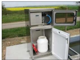
Parallèlement, des préleveurs automatiques et réfrigérés en entrée et sortie de station permettent de réaliser les prélèvements d'échantillons sur 24h. Ceux-ci sont ensuite envoyés à un laboratoire d'analyses agréé.
