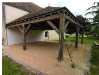
Travaux de rafraîchissement derrière la salle Georges Vigot
